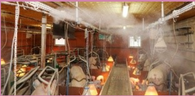
Le nuage de brume qui s'observe jusqu'à 3 ou 4 mètres de distance s'évapore avant d'atteindre les animaux. ©D. Poilvet
