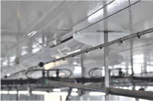
▲ **L'installation des rampes de brumisation est importante** pour assurer le bon fonctionnement du système et donc un refroidissement efficace. La brume doit être diffusée dans le flux d'air.
